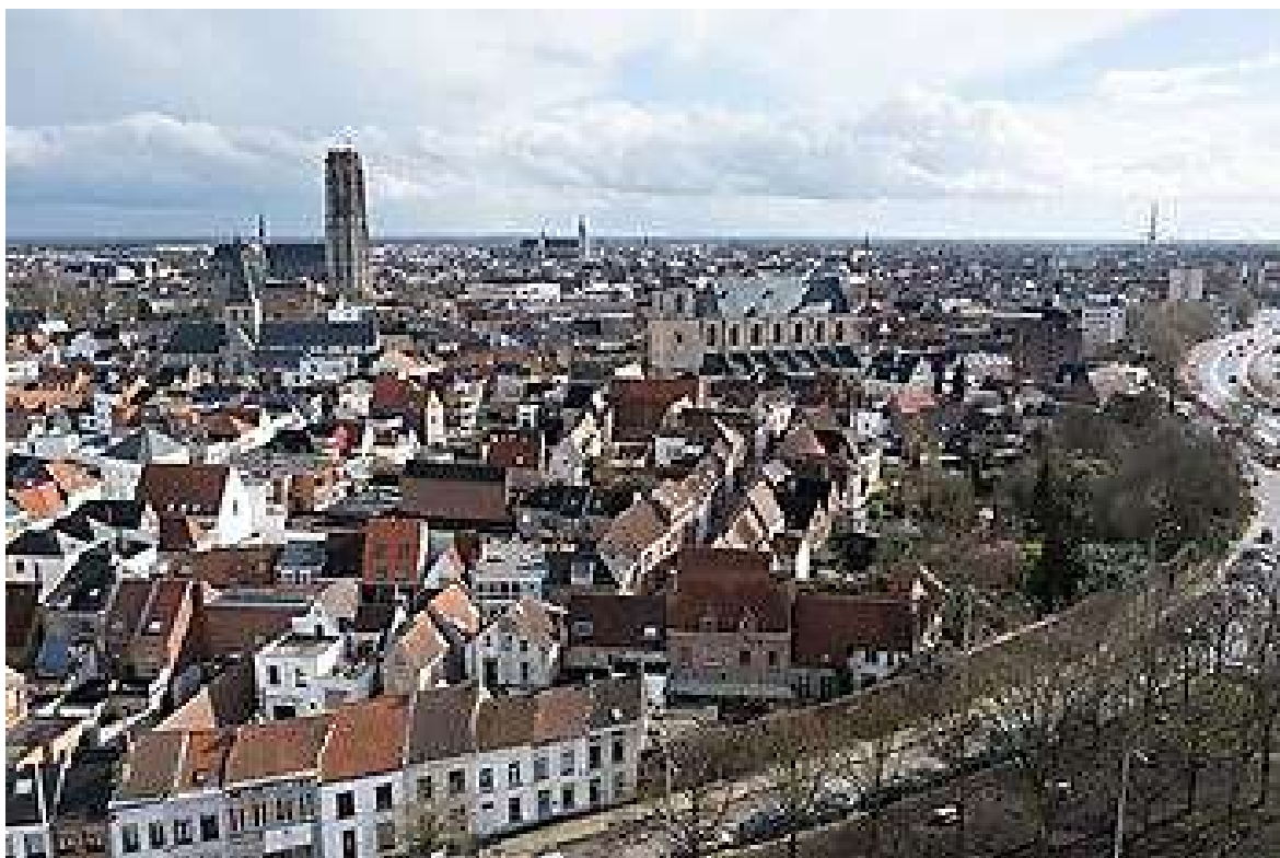
Afbeelding 13 De 17de-eeuwse bakstenen Centjesmuur (rechts) sloot het begijnhof af aan de vestzijde. In de loop van de 19 e eeuw werd een deel van de Centjesmuur vervangen door een 7-tal huizen (links).
