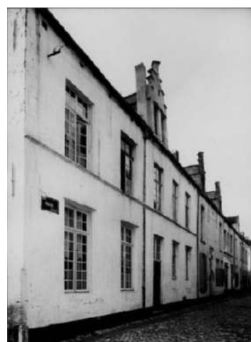
Afbeelding 9 Hoviusstraat aangelegd in de 17 de eeuw met uniforme begijnhofwoningen © Beeldbank Mechelen
