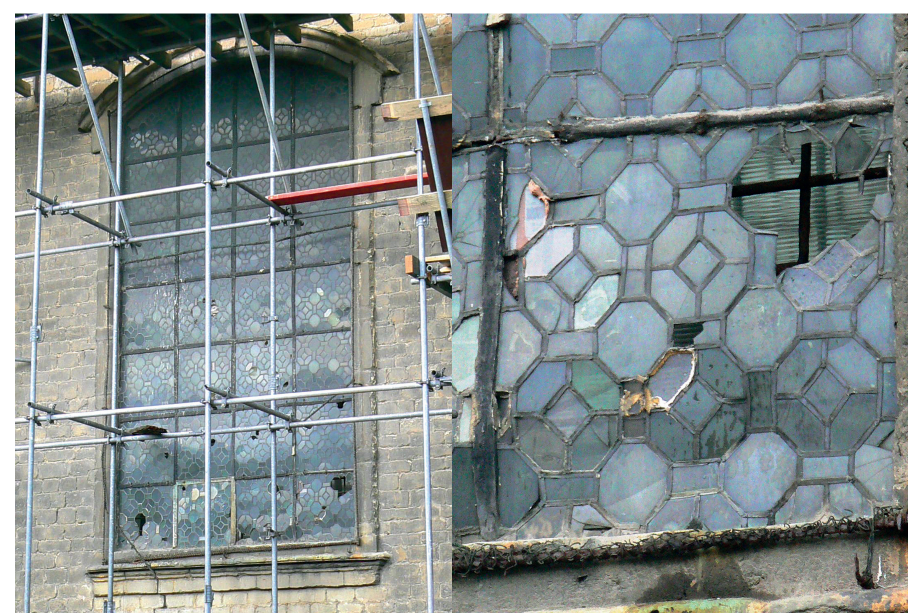
Blanke glas-in-loodramen (foto Dienst Monumentenzorg)
