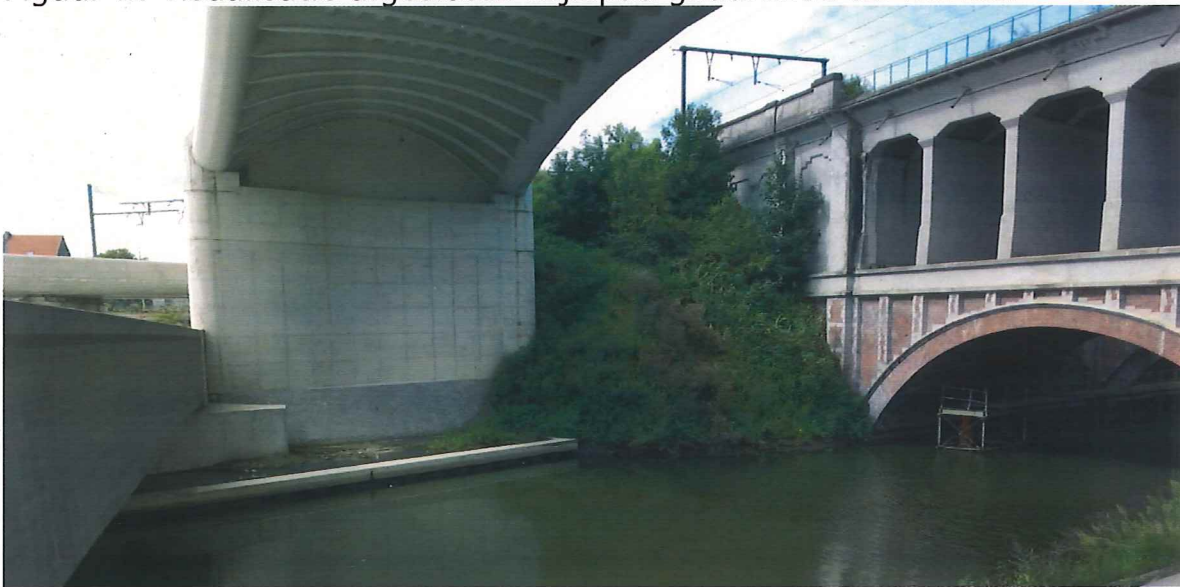
uur 2: zicht op opgebroken staketsel onder de nieuwe brug en bestaande staketsel onder de bestaande spoorbrug
