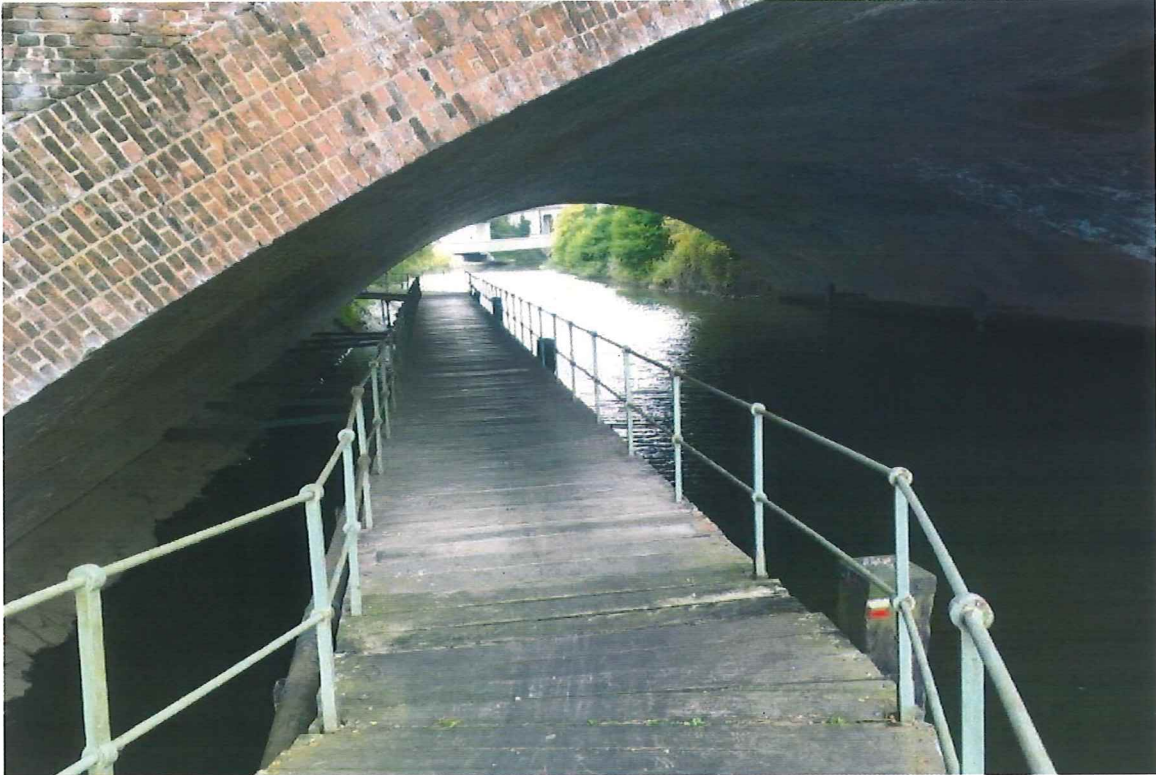
Figuur 3: staketsel onder spoorbrug L27B (in de verte zicht op nieuwe bruggen B) Renovatie Dijlepad
