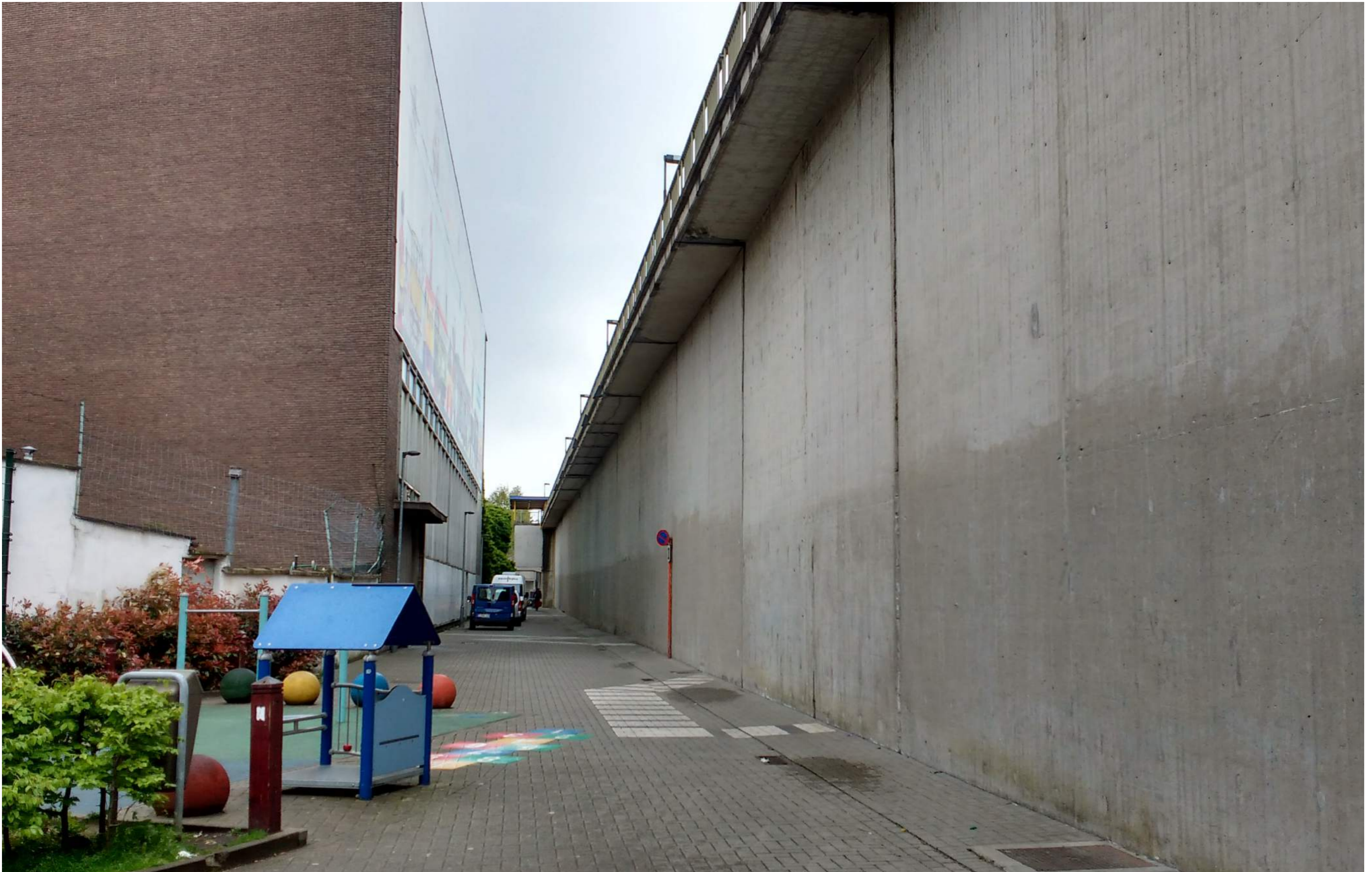
1980 - Verleggen van de sporen tot tegen speelgoedmuseum - aanleg N15 en Nekkerhal
