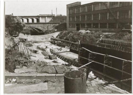
1978: aanleg van parking Zandpoortvest en constructie van koker
