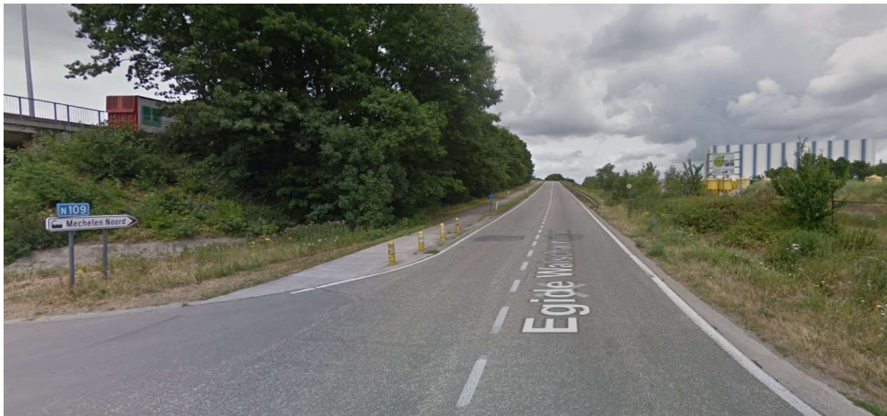
Figuur 28: N109 met vrijliggend dubbelrichtingsfietspad (Bron: Streetview)
